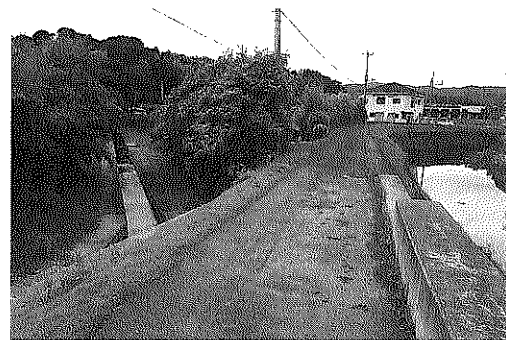
水車があった流れが、改修後の東連津川に交わる地点
