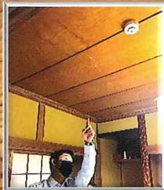
火災報知機の点検
