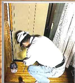
雨戸のカギの修理
