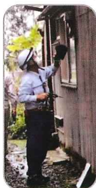
電気系統の点検
