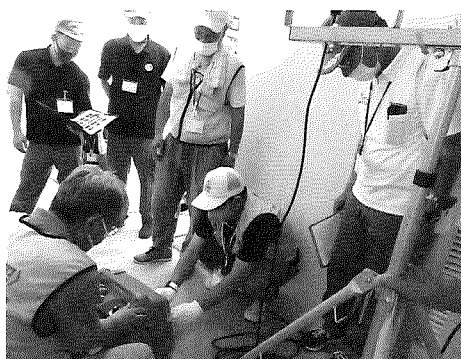
発電機の動作確認
