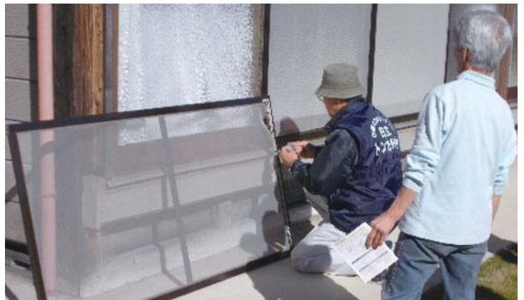
網戸の破れた箇所を修繕
