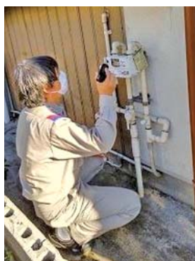
ガスの点検 (東京ガスネットワーク(株)日立支社)
